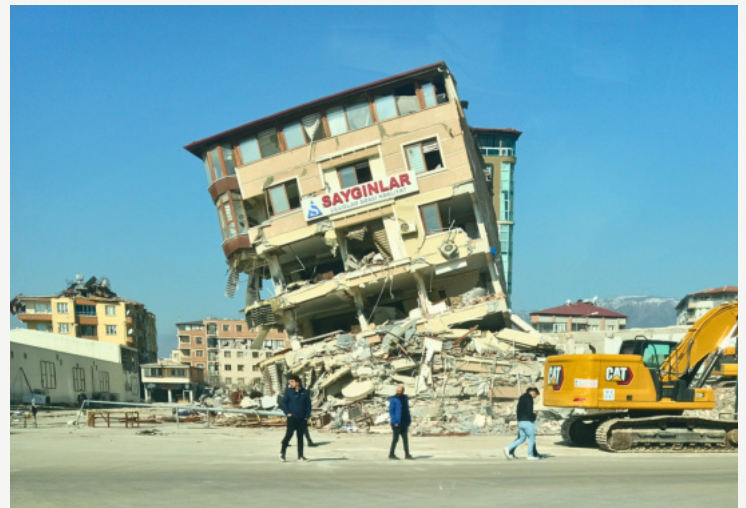
Die meisten Todesopfer befanden sich in den unteren Etagen, welche auch aufgrund unzureichender Statik einstürzten.
